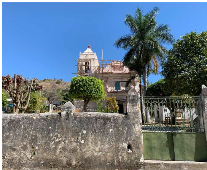
Figura 11. Iglesia de Atzala. Fuente: Propia, 2019.
